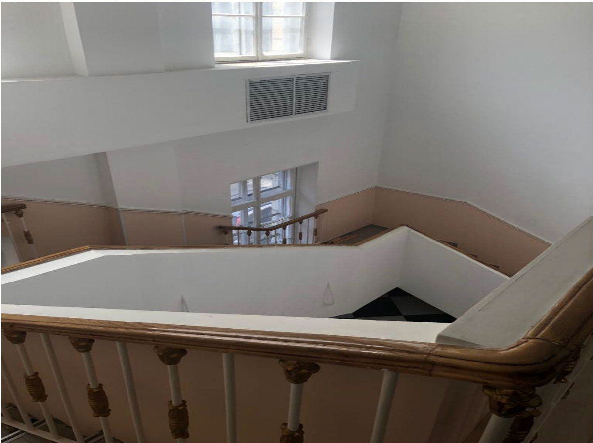
Лестница на 2 этаж
